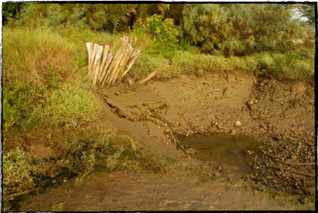
Foto 3. Obra de drenaje (ODI) debajo del camino.
