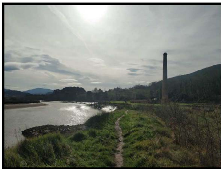
Tejera (posible zona de acopio)
