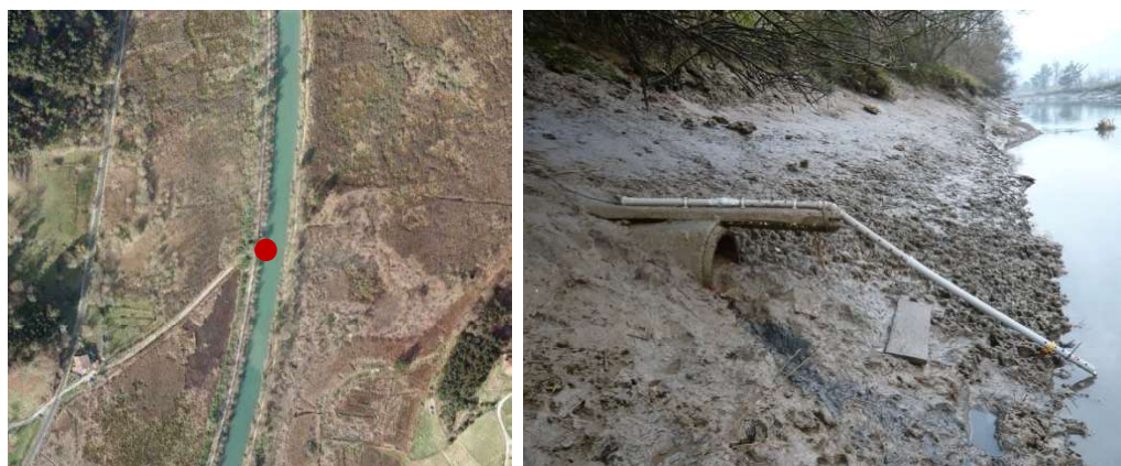
Figura 3.7.- Emplazamiento e instalación de la sonda 5
