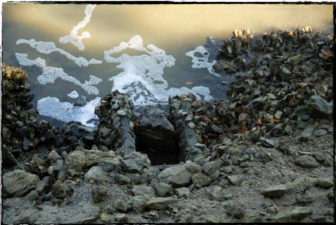
Foto 12. Obra de drenaje (OD) debajo de la muna y que conecta el agua del lado sur con el del canal principal del Oka.
