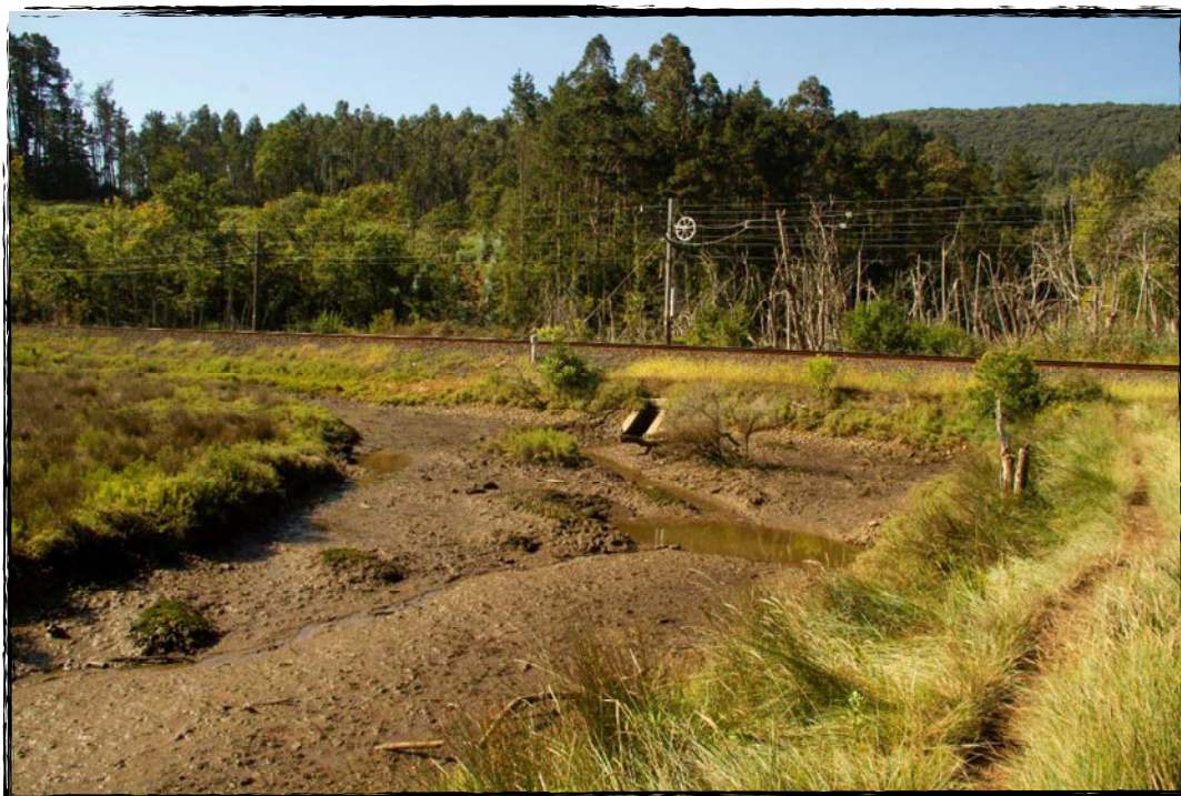
Foto 20. Muna con el camino en su cresta, en el tramo que enfila hacia las vías del tren. A la izquierda se observa el canal que discurre desde la OD bajo las vías del tren.
