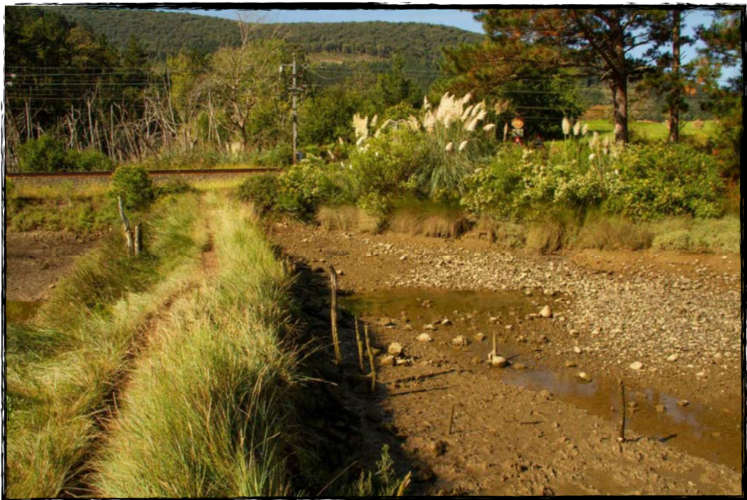
Foto 19. Muna con el camino en su cresta, en el tramo que enfila hacia las vías del tren. A la derecha entra un brazo del canal principal del Oka.
