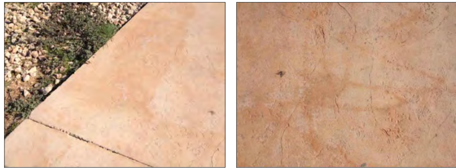
DETALLE TEXTURADO PAVIMENTO HORMIGÓN IMPRESO EXISTENTE EN EL ENTORNO PRÓXIMO, IMITACIÓN PIEDRA MARÉS NATURAL
