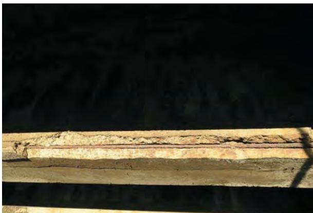
*Desconche en ala inferior por corrosión de las armaduras. Armadura vista*
