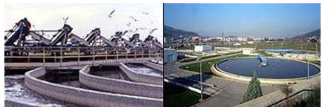
Un 30 % de la población catalana se verá beneficiada por las obras de ampliación de la estación depuradora de Sant Adrià de Besòs
