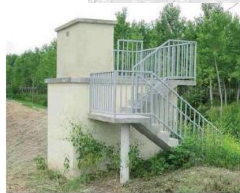
Figura 8. Transformador eléctrico sobrelevado situado en la zona inundable del Rio Garona.
