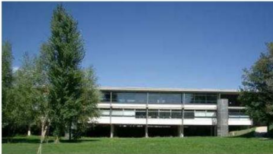
Figura 6. Ejemplo de edificio pilotado: mediateca de Gardanne (Francia). Fuente: Dirección Regional de Medio Ambiente de Languedoc-Roussillon en colaboración con el CETE
