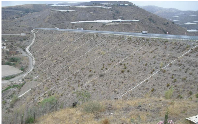
Imagen 33. Detalle del terraplén de la autovía (A-7).
