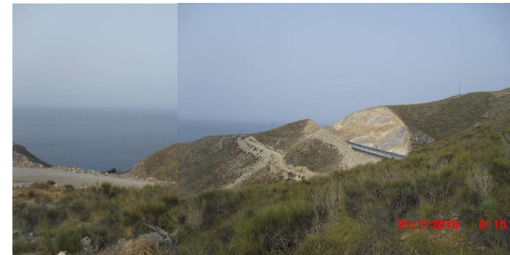
Imagen 13. Panorámica de la pista de servicio de la Conducción La Contraviesa y taludes de la autovía (A-7) desarrollados en estos materiales
