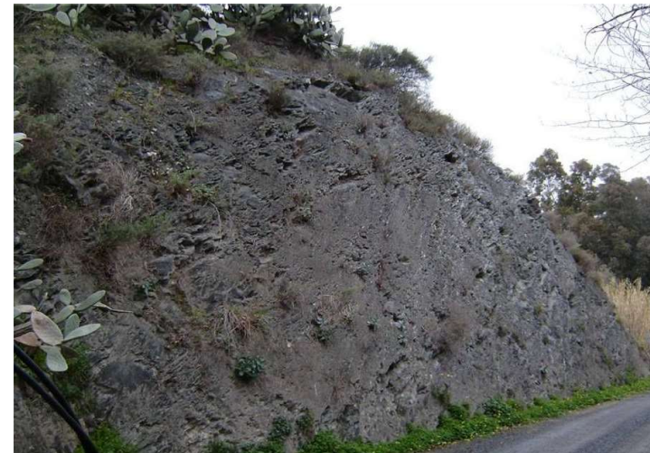
Imagen 7. Talud en las filitas del Manto del Alcázar
