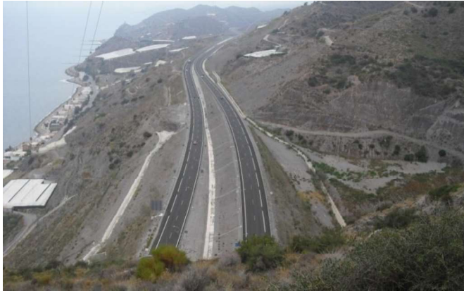
Imagen 32. Aspecto de los terraplenes junto a la boquilla del túnel de la A-7.
