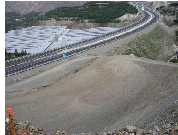
Imagen 31. Rellenos antrópicos, junto al terraplén de la Autovía del Mediterráneo.
