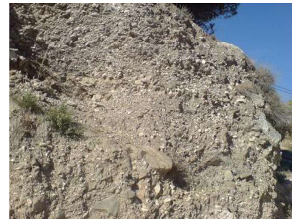
Imagen 23. Talud excavado en conglomerados pliocenos junto a Molvízar.
