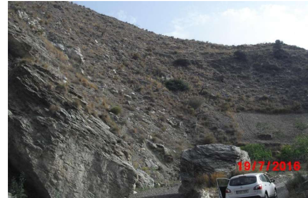
Imagen 51. Zona con grandes bloques caídos en el fondo del barranco.
