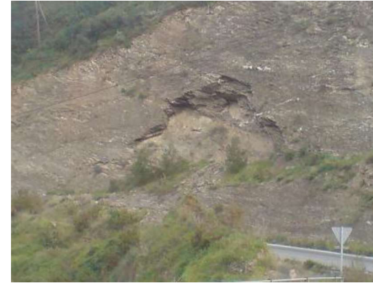
Imagen 15. Desprendimientos en taludes excavados en micaesquistos MS-1 del Manto de Salobreña en la carretera de Itrabo a Jete
