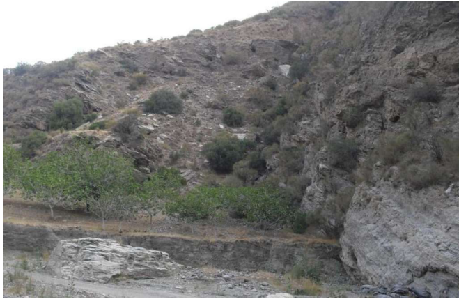
Imagen 53. Zona con materiales deslizados.
