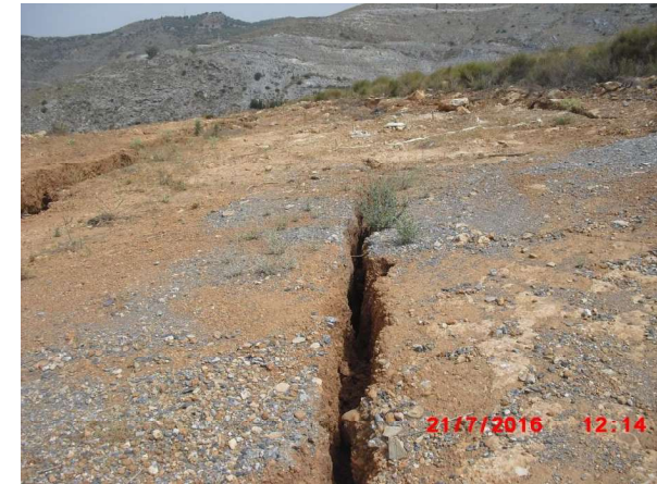
Imagen 55. Detalle de una de las grietas de tracción abiertas.
