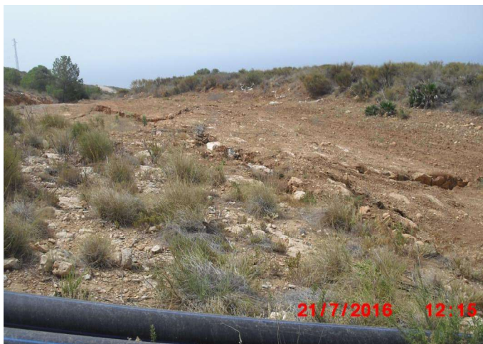
Imagen 54. Vista general de la zona del deslizamiento.
