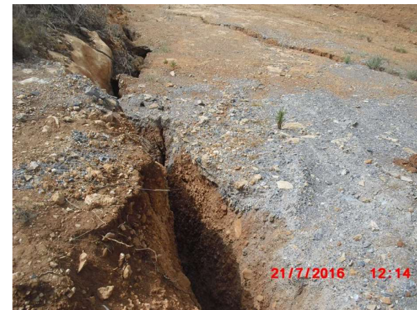
Imagen 56. Otro aspecto de las grietas de tracción abiertas.
