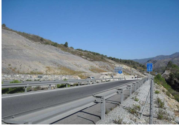
Imagen 8. Panorámica de los taludes de la autovía A-7.
