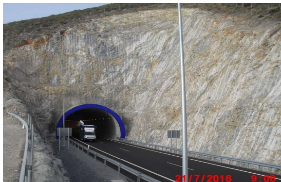
Imagen 11. Taludes de emboquille desarrollados en esta unidad
