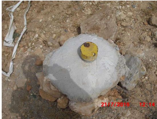
Imagen 57. Detalle de inclinómetro para controlar los movimientos de la ladera.
