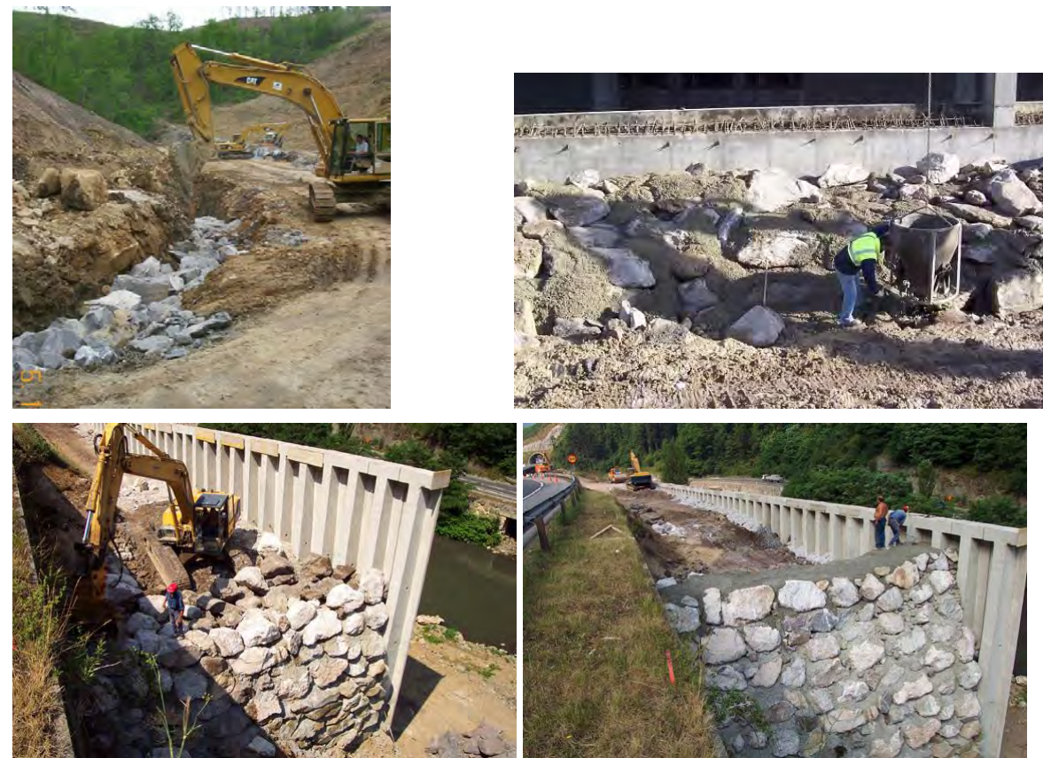
Figura 14. Sección de zanja con sostenimiento mediante muro de escollera (arriba) e imágenes de cómo se ejecuta (abajo).
