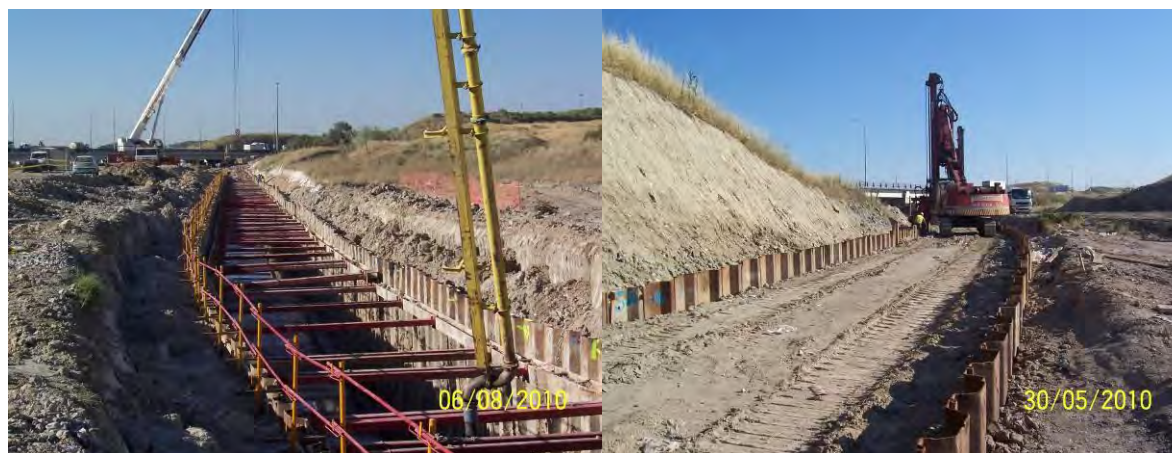
Ejemplos de líneas de tablaestacas para contención de tierras.
