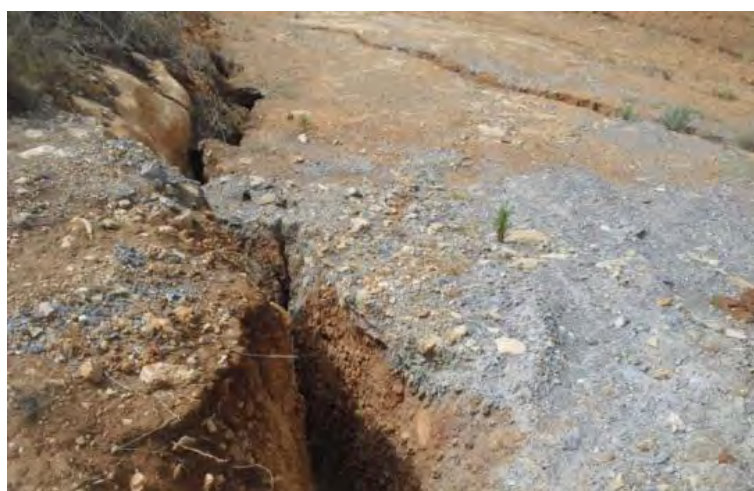
Otro aspecto de las grietas de tracción abiertas.
