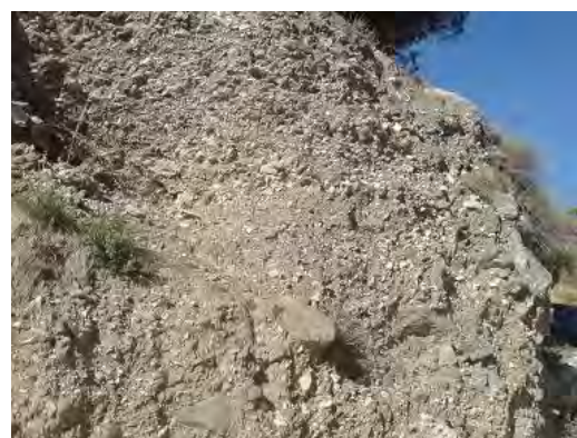
Talud excavado en conglomerados pliocenos junto a Molvizar.
