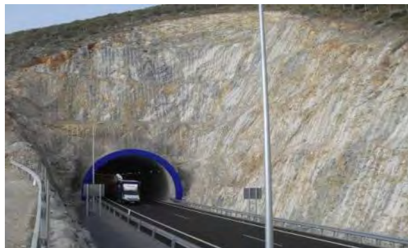
Taludes de emboquille desarrollados en esta unidad.
