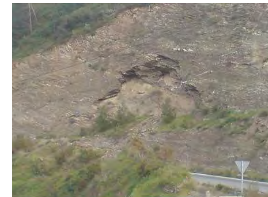
Desprendimientos en taludes de micaesquistos MS-1 en la carretera de Itrabo a Jete.
