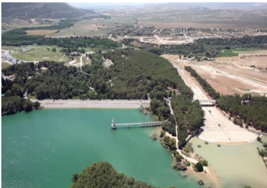
Ilustración 2. Presa de Cubillas.
