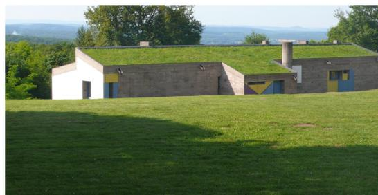
Figura 24. Cubierta vegetada plana extensiva y Cubierta inclinada vegetal.
