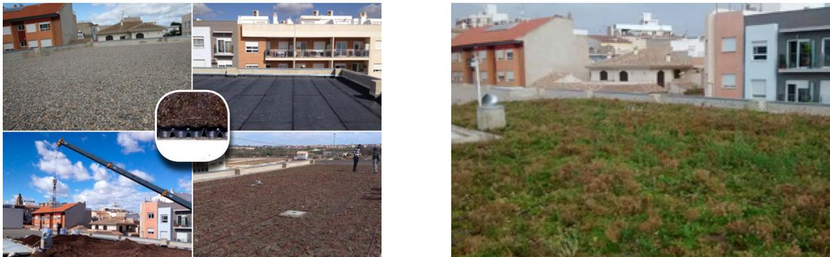
Figura 64. Construcción de la cubierta y resultado final de la cubierta vegetada.
