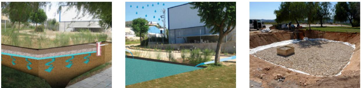
Figura 62. Construcción y esquemas de funcionamiento del depósito de retención.
