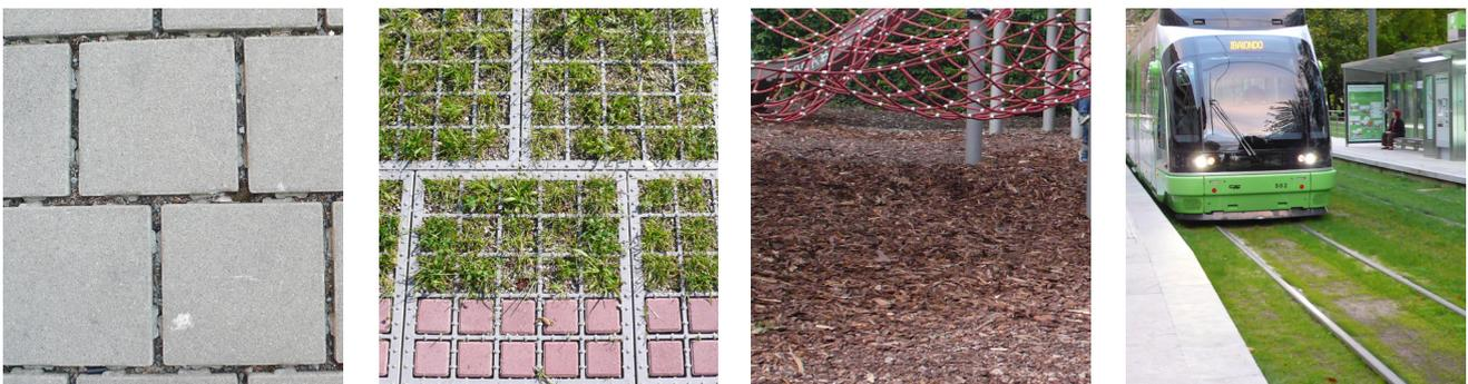
Figura 26. Pavimento permeable por junta y mediante celda. Pavimentos disgregado mulch y vegetal.
