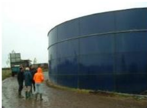
Figura: Tanque de almacenamiento de purines
