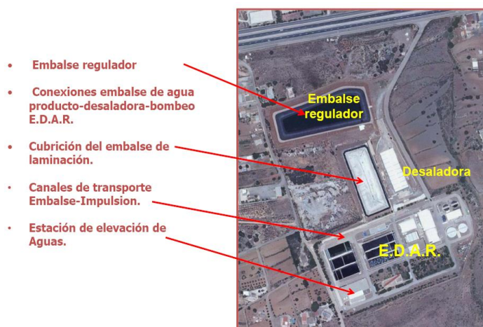
Figura 9: Vista general de la Instalaciones de Arco Sur.
