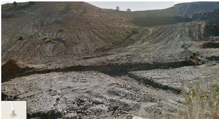
Figura 18: Coladas de sedimentos en el tramo superior del encauzamiento de la rambla del Beal
