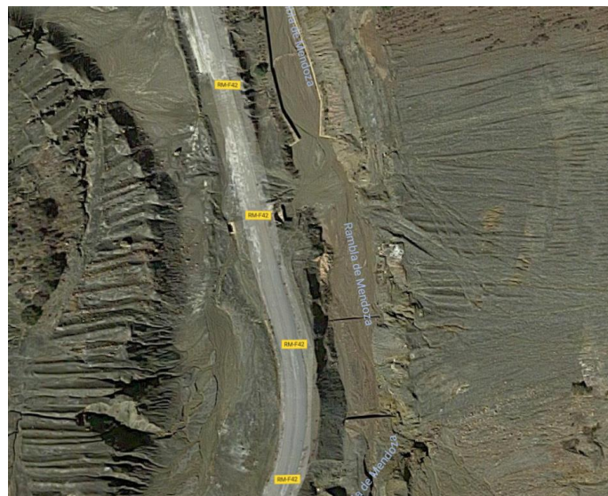
Figura 17: Tramo superior del encauzamiento de la rambla del Beal, aterrado
