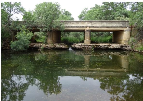
Foto 45: Puente descalzado por socavación del lecho en la RNF Río Milagro. DH Guadiana.
