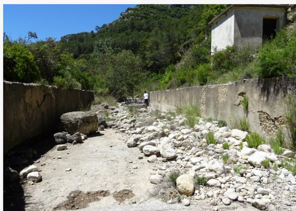
Foto 42: Cauce canalizado y hormigonado de la antigua estación de aforo del Cenía. RNF Río Cenía. DH Júcar.
