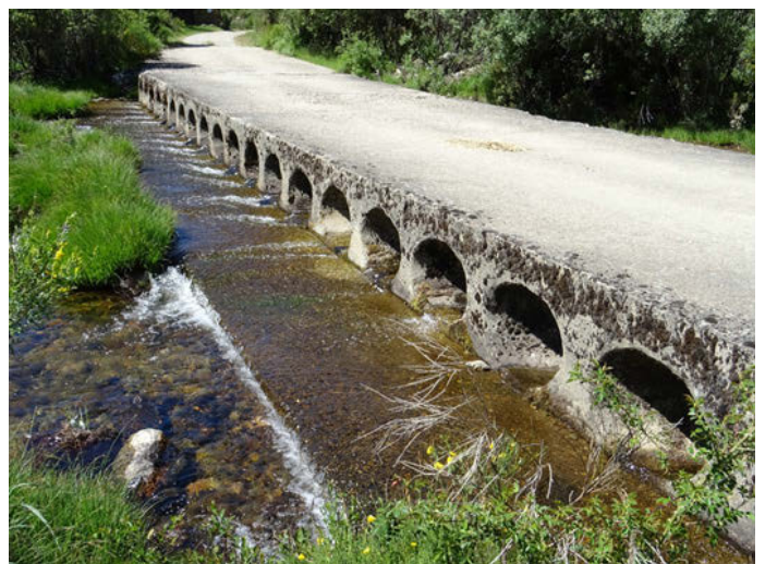
Foto 6: Paso entubado en el río Bibey
