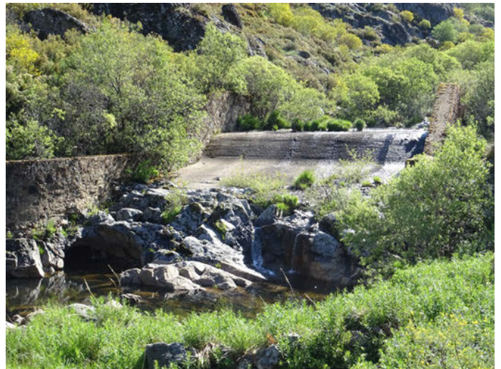
Foto 4: Azud para el trasvase de agua al embalse de Valdesirgas
