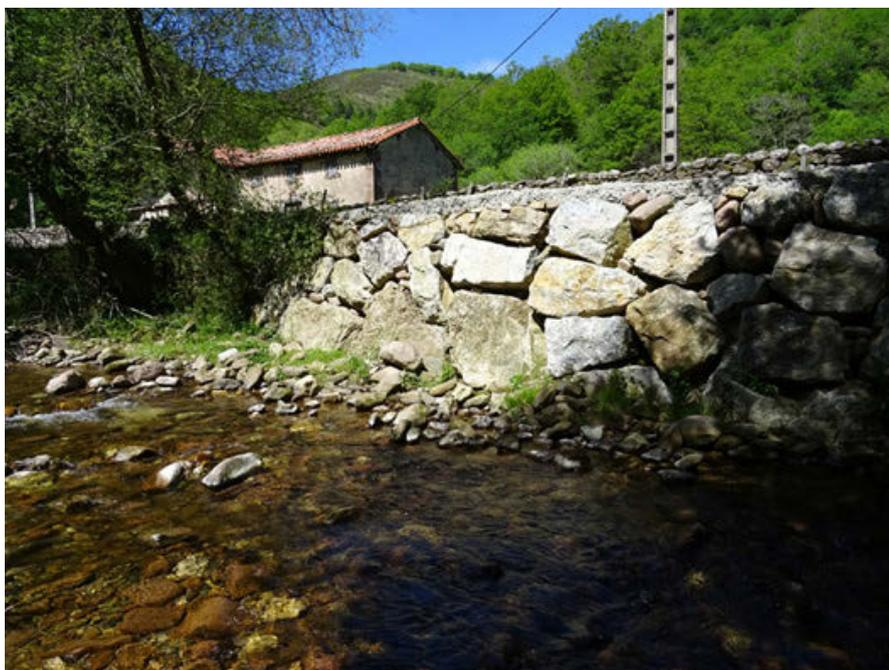
Foto 9: Muro de protección para pista
