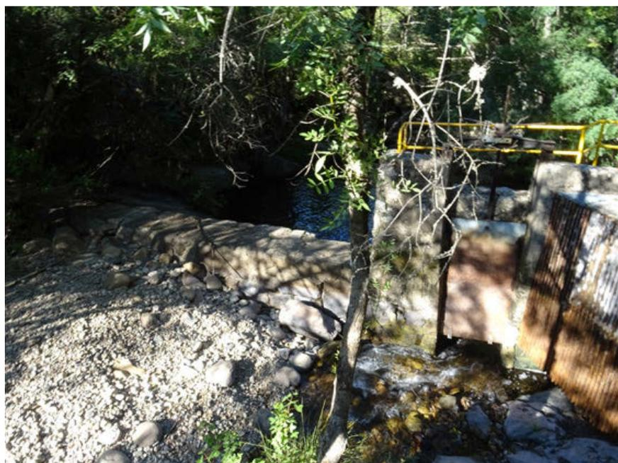
Foto 9: azud de Casas del Conde donde se aprecia la colmatación del remanso.
