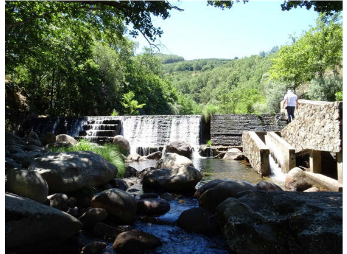
Foto 2: Presa de abastecimiento de Cabezuela del Valle, en la parte intermedia de la Zona 2 de la RNF
