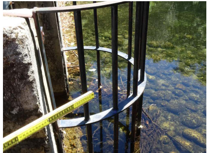
Foto 4: Detalle de la salida de la escala de peces al vaso muy colmatado del embalse en la presa de abastecimiento de Cabezuela del Valle
