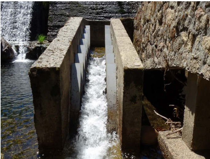
Foto 3: Detalle de la escala de peces en la presa de abastecimiento de Cabezuela del Valle
