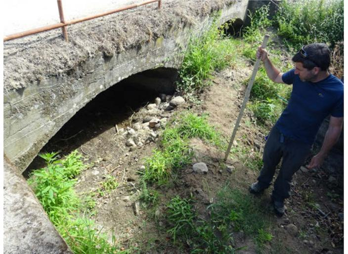
Foto 26: Puente colmatado por un azud casero con una toma de agua
