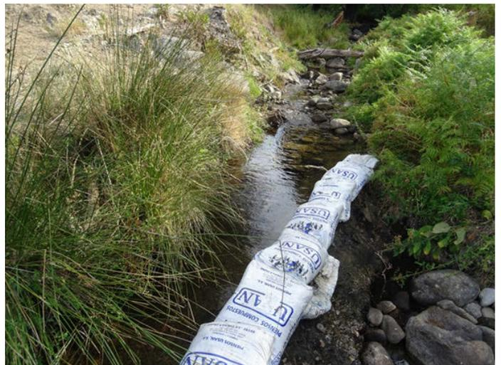
Foto 12: Azud de derivación para las balsas de riego (zona 2)
