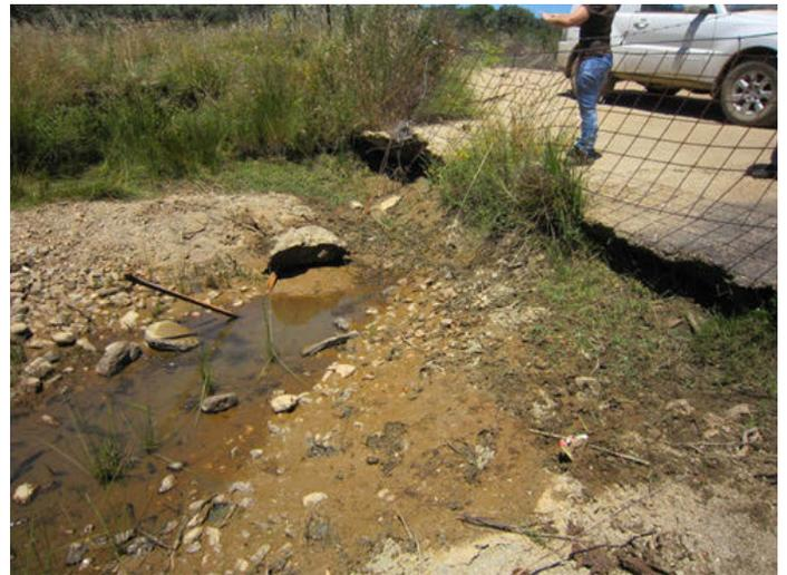
Foto 4: Detalle del vado de la foto anterior, mostrando descalce.
