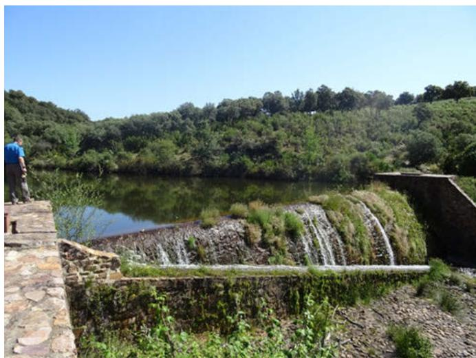
Foto 10: Presa con escala para peces en la finca El Avellanar, río Frío (afluente del Estena)
