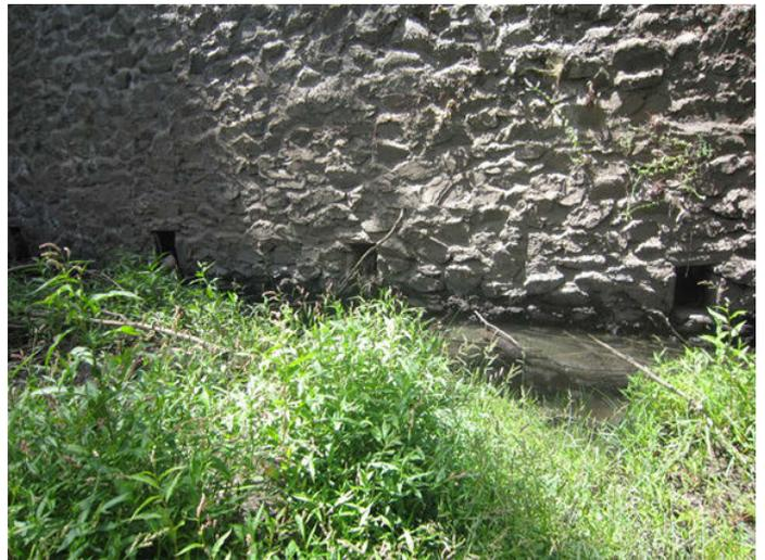
Foto 39: Base del azud de contención mostrando los sumideros por donde se filtra el agua
