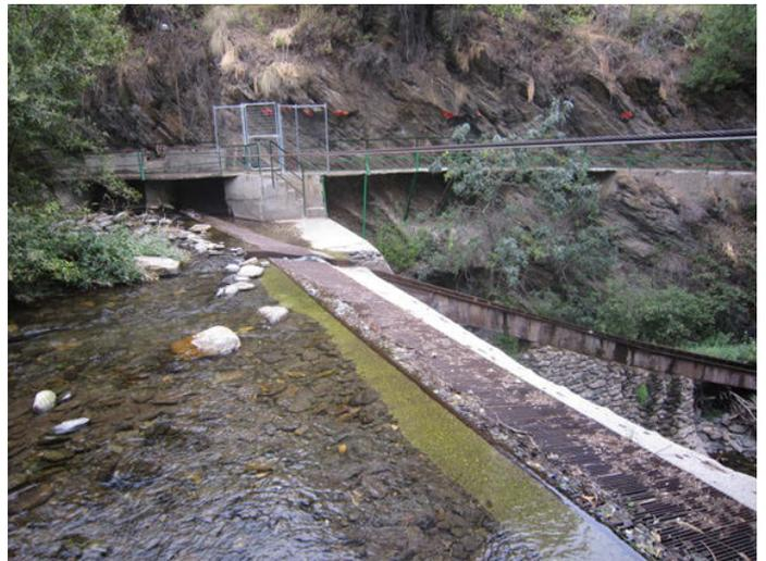
Foto 16: Azud sobre el río Genil, aguas abajo de Aº de San Juan: con escala para peces y rejillas en coronación, para toma de agua de acequia
