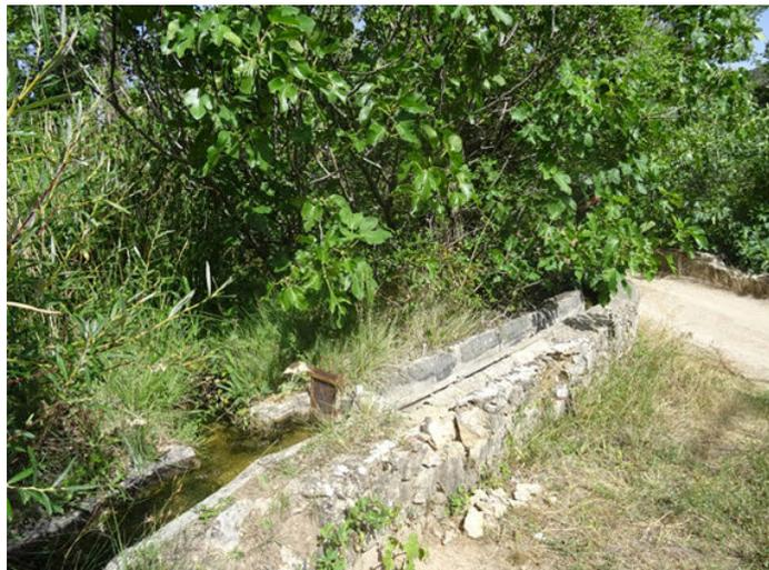
Foto 8: Acequia de riego junto a puente de Parideras; la compuerta cerrada deriva el agua transportada desde aguas arriba, hacia el cauce del río Salobre.
