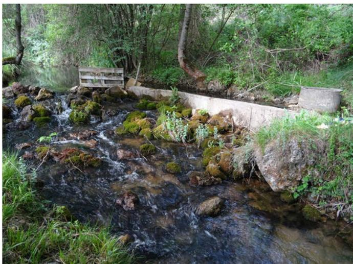
Foto 17. Azud en desuso con canal lateral ubicado el tramo bajo del A. de los Endrinales
