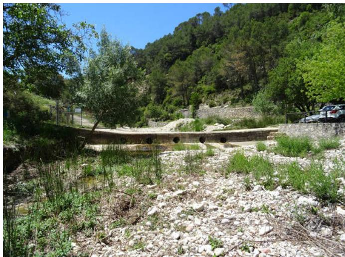
Foto 12. Paso entubado para el acceso al vivero forestal de Forn del Vidre en la RNF del Cenia
