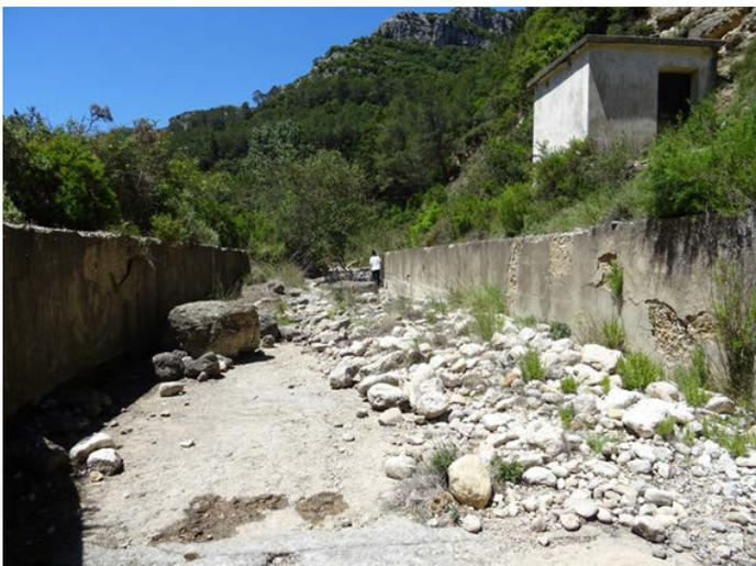
Foto 11. Cauce hormigonado de la antigua estación de aforo del Cenia
