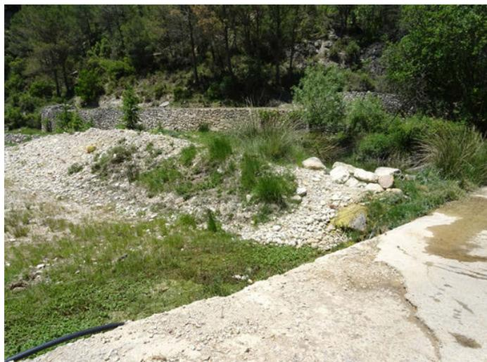
*Foto 14. Mota en el cauce formando una balsa artificial que retener el agua del Bco. de Tenalla*
