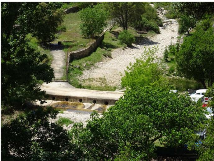
Foto 9. Paso entubado y muros de piedra pegados al cauce fluvial de la RNF del Cenia
