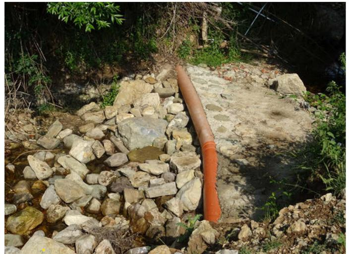
Foto 4: Obstáculo de hormigón y tubería cruzando el cauce en Canales de la Sierra.
