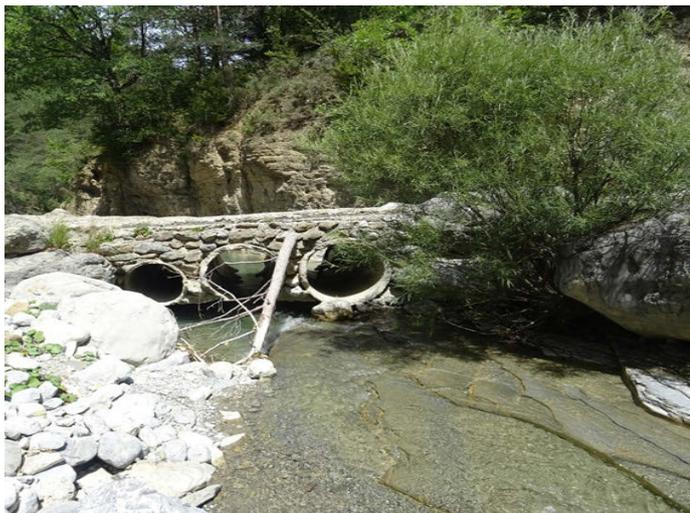
Foto 7. Puente sobre paso entubado, descalzado por la acción erosiva del agua.
