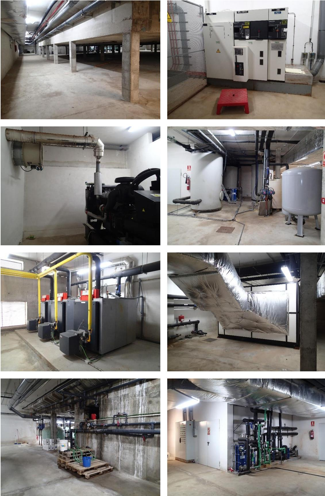
Fig. 34: Sótano del edificio de piscinas. Centro de transformación, grupo electrógeno, depósitos de agua caliente sanitaria, cuarto de calderas, deshumectadora, depuradora y otras instalaciones vinculadas al funcionamiento de las piscinas.
