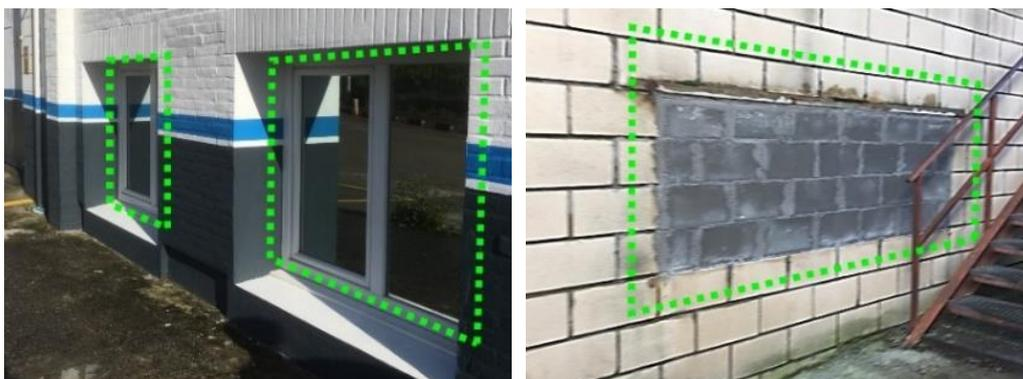
Fig. 51. Ejemplo de medidas de autoprotección en el Polígono Industrial de Marrón (Ampuero, Cantabria): cristales blindados y sellado permanente de huecos.
