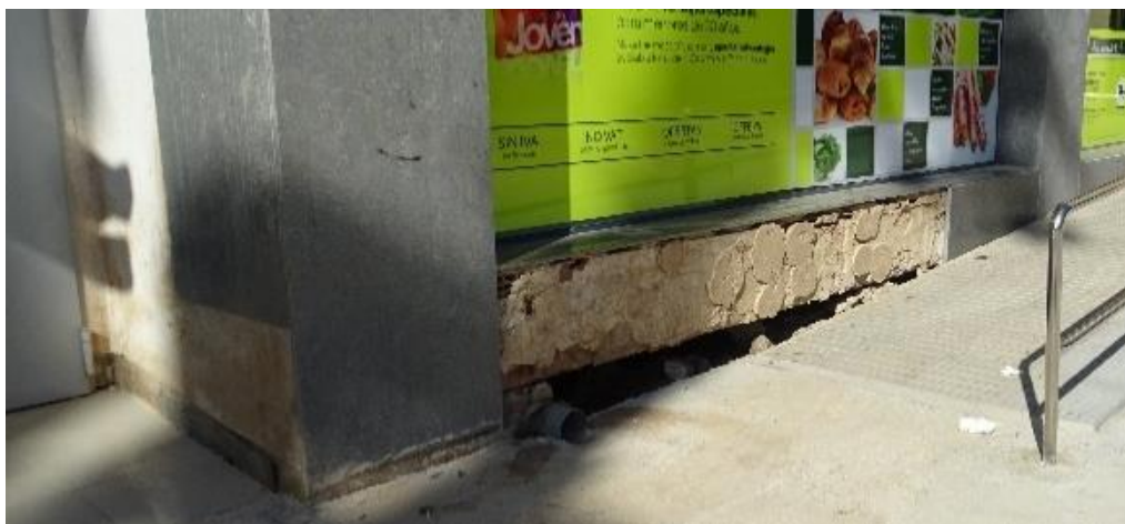
Fig. 19: Principales puntos de entrada de agua.
