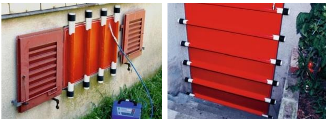
Fig. 35: Ejemplos de sellado puntual provisional. Flood proofing in urban areas. 2019.
