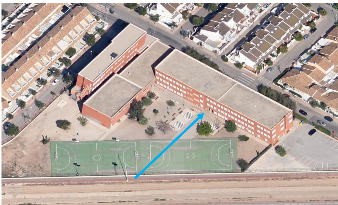
Fig. 20: Dirección de la escorrentía y principal punto de entrada de agua. Visor MINHAP.
