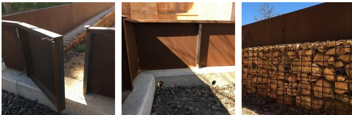
Fig. 41: Instalación de compuertas en el muro noroeste para evacuación del agua en caso de colapso del muro sudoeste.
