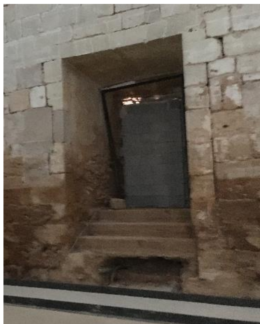
Fig. 27: Entrada de agua en el edificio a través de los huecos de la sala “De Profundis” en el evento de 2018.
