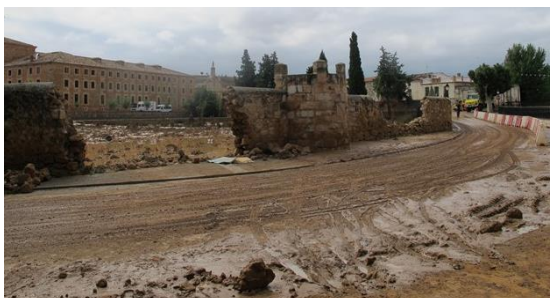
Fig. 12: Inundación de septiembre de 2018: rotura del muro adyacente al barranco del Tejar (entrada de agua) y del muro del paseo de la Estacada (salida de agua). Monasteriohuerta.org
