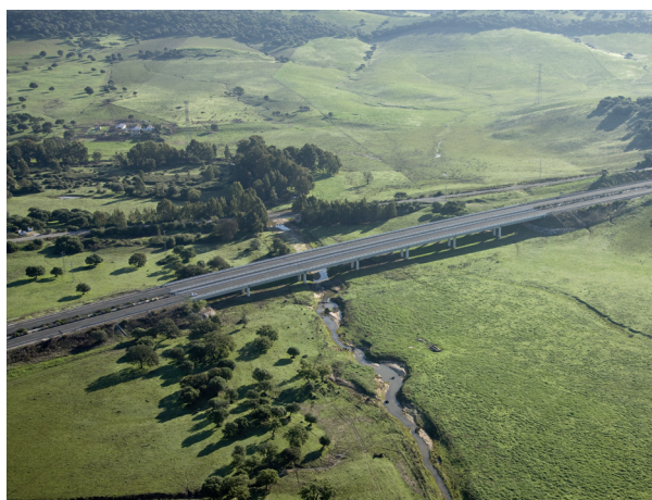
Figura 2.2. Mosaico de hábitats en un paisaje y efecto barrera de una vía de transporte, que en este caso se ha reducido mediante la construcción de un viaducto. Fotos Minuartia y GIASA, Junta de Andalucía.
