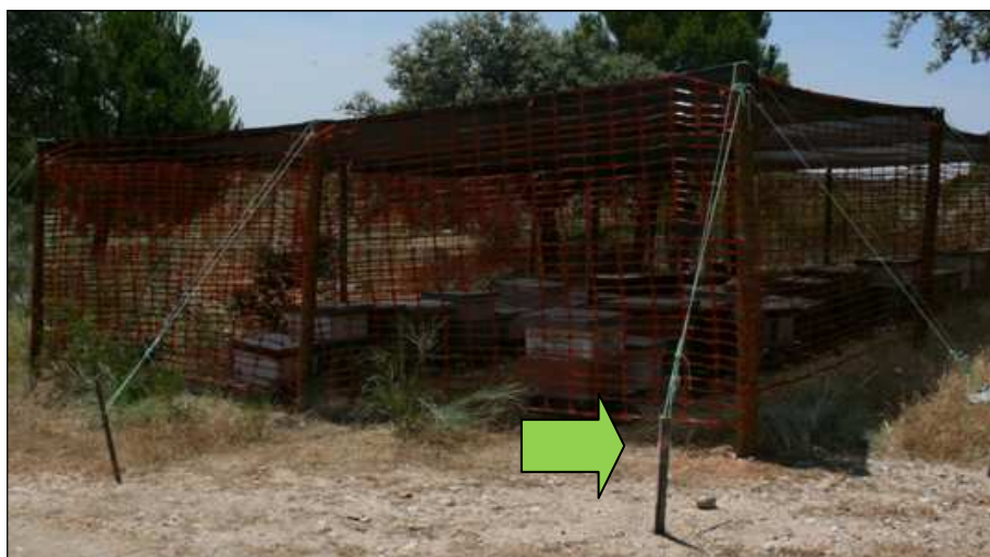
Figura 2: Sistema de tensores de sujeción de la estructura
