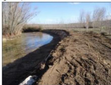
Figura 7 | Construcción de la mota de protección.
