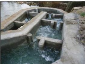
Figura 12 | Detalle de artesas, deflectores y escotaduras de la escala de peces.
