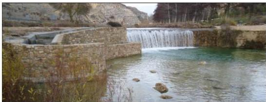
Figura 11 | Escala de peces terminada.
