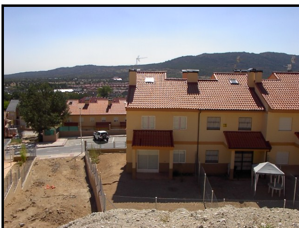
Imagen 23: Materiales incombustibles (0 pts.)
