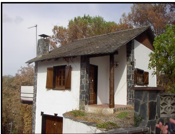
Imagen 27: Porches y balcones de material combustible.
