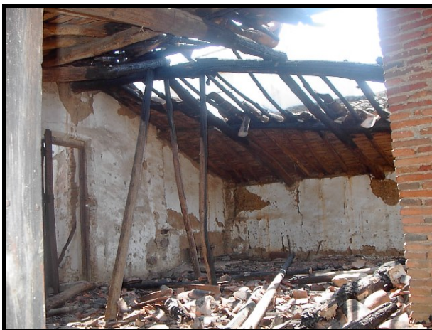
Imagen 24: Uso de Troncos y vigas de madera en la construcción (1 pto.)
