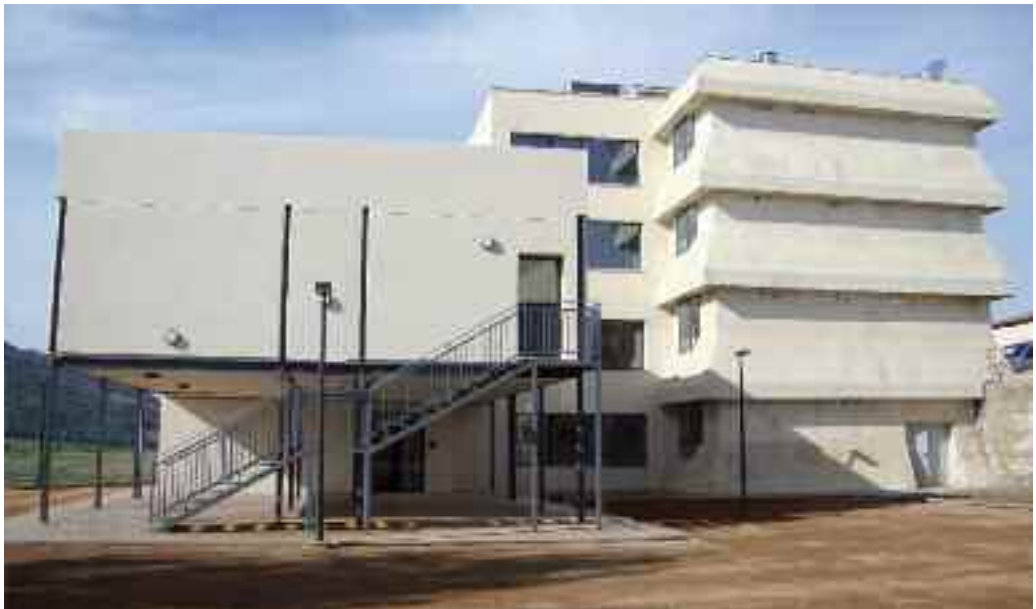
Figura 12. Centro Tecnológico Nacional de Descontaminación del Mercurio
