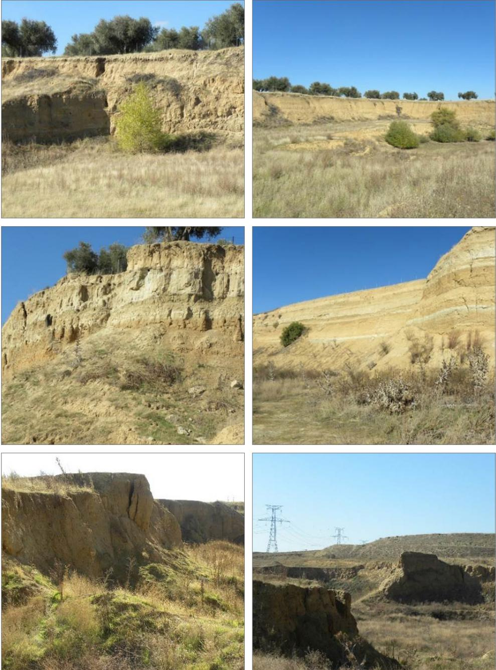
**Figura 18.** Estado erosivo e inestabilidades de los taludes del hueco de explotación de la cantera Valanzana
