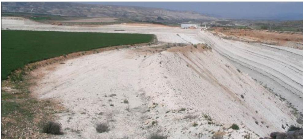
**Figura 6.** Relleno y rehabilitación del hueco de una explotación de sepiolita mediante la transferencia de los estériles en Calatayud (Zaragoza)
