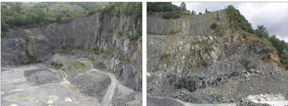
**Figura 13.** Taludes de huecos excavados en rocas duras con distinto grado de fracturación y alteración
