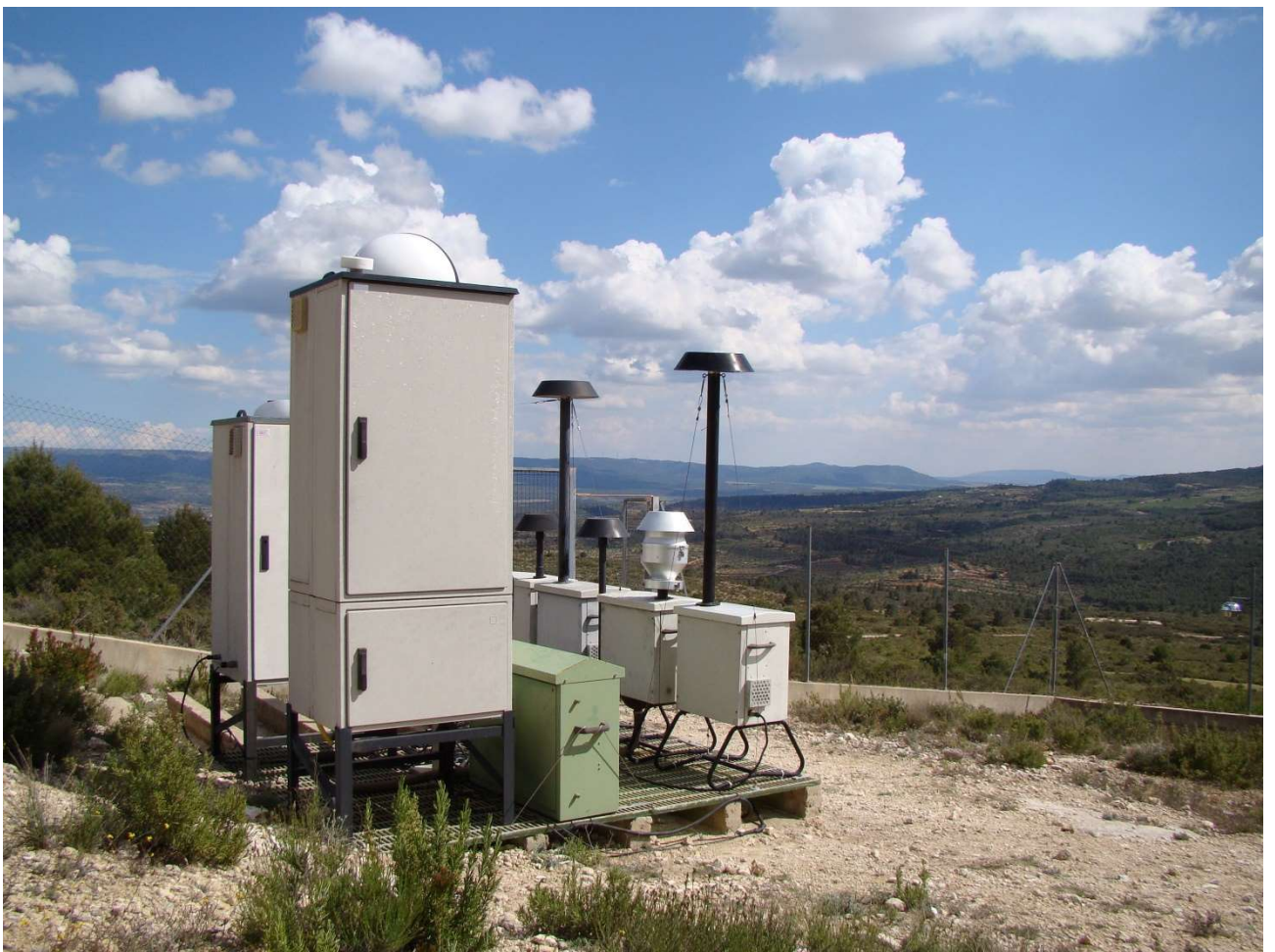
Estación EMEP de Zarra (Valencia)
