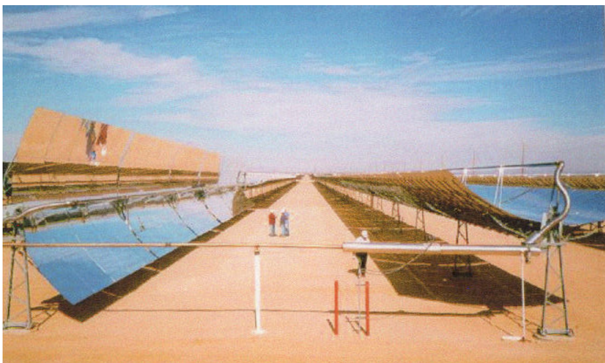
Figura 1. Instalación de colectores Cilindroparabólicos
