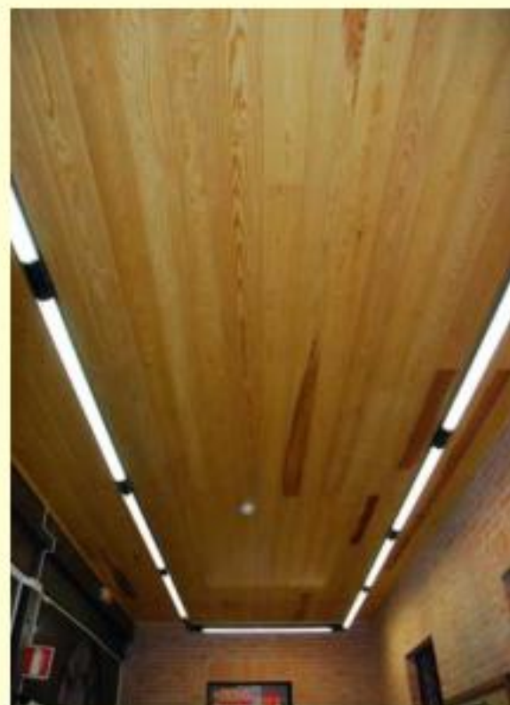
Falso techo en el porche este del CENEAM
