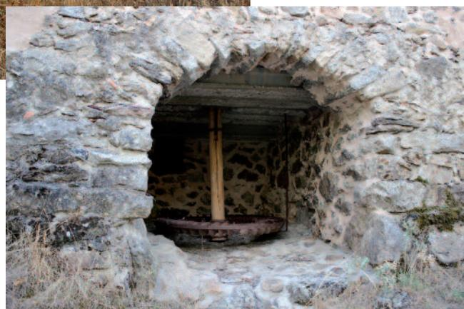
**Figuras 26.-** Molino del Romo (o del Pirón) de Santo domingo del Pirón y detalle de su rueda horizontal o rodezo (L. A. Carreño).
