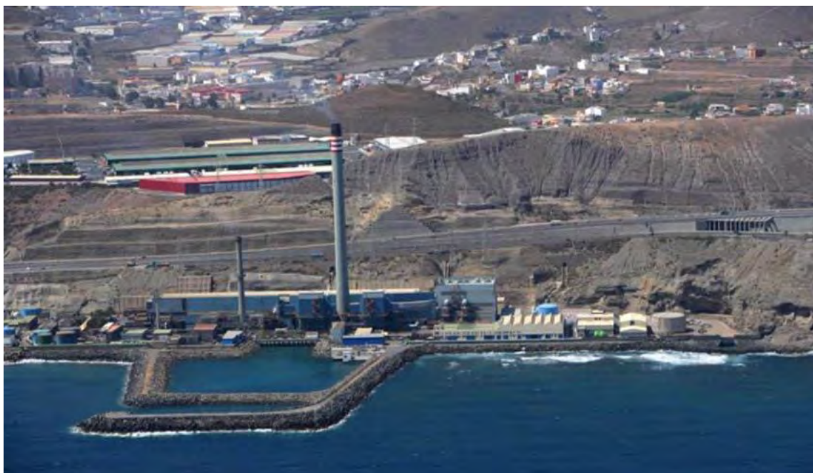
Figura 138. Diques de la desaladora Las Palmas III.
