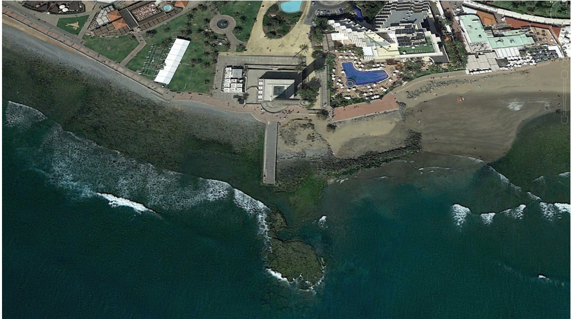
Figura 20. Imagen aérea del espigón actual del Faro de Maspalomas.
