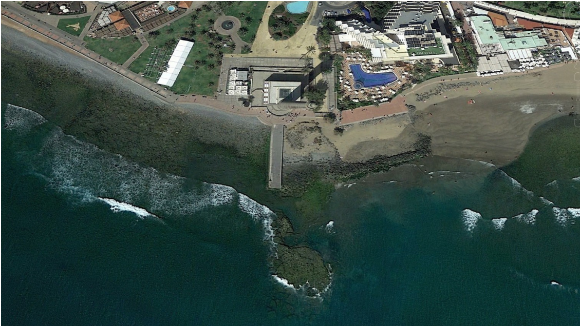
Figura 24. Imagen aérea del espigón actual del Faro de Maspalomas.
