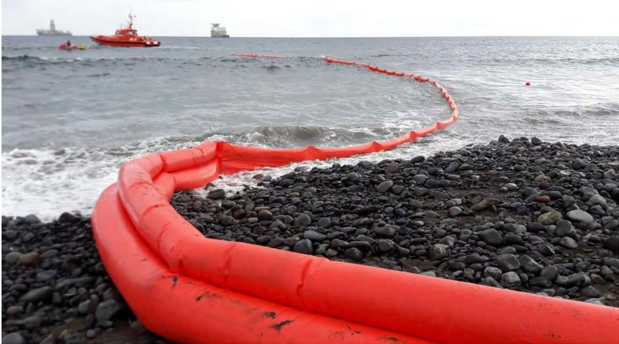
**Figura 22.** Remolque de la barrera por la embarcación Nunki de SASEMAR.
