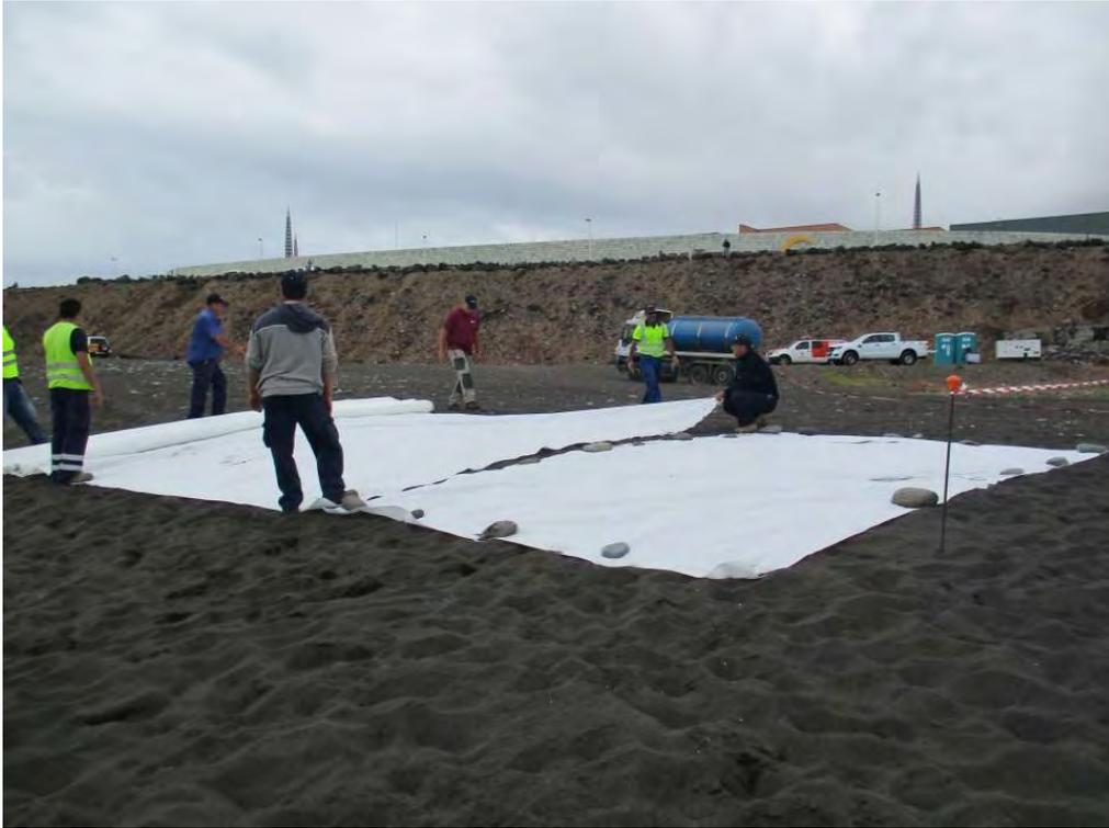
**Figura 12.** Personal interviniente estableciendo la zona de protección de geotextil.
