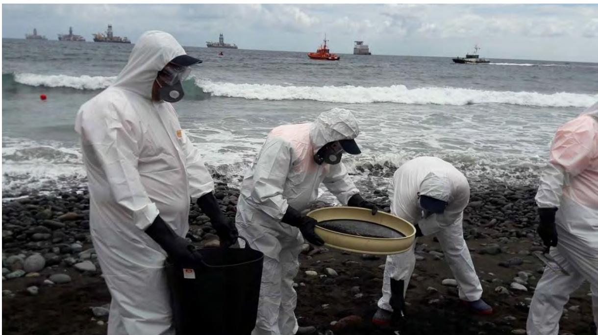
**Figura 25.** Tamizado de arena contaminada.
