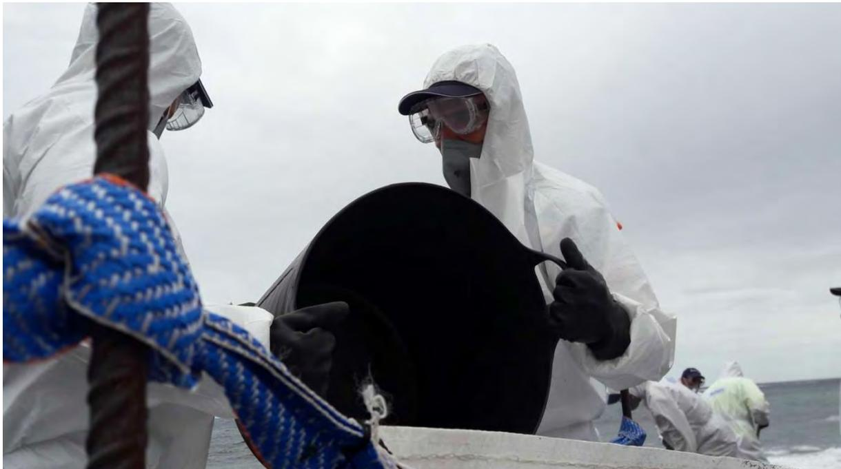
**Figura 24.** Vertido del hidrocarburo recogido en las sacas big-bag.
