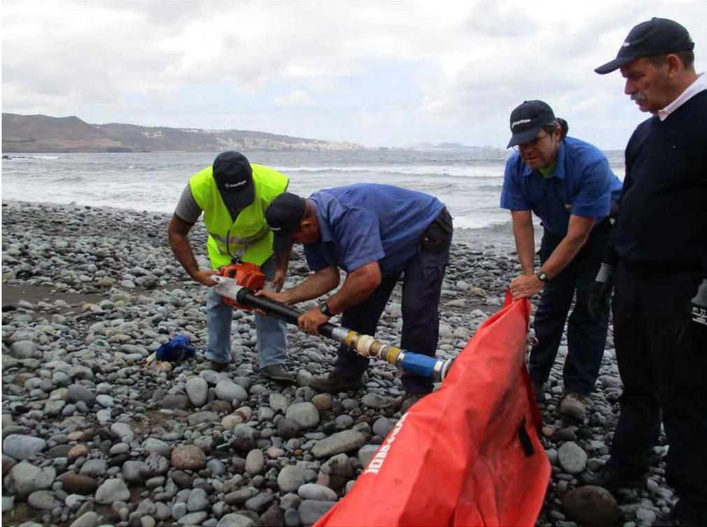
**Figura 13.** Inflado de la cámara de aire de la barrera selladora.
