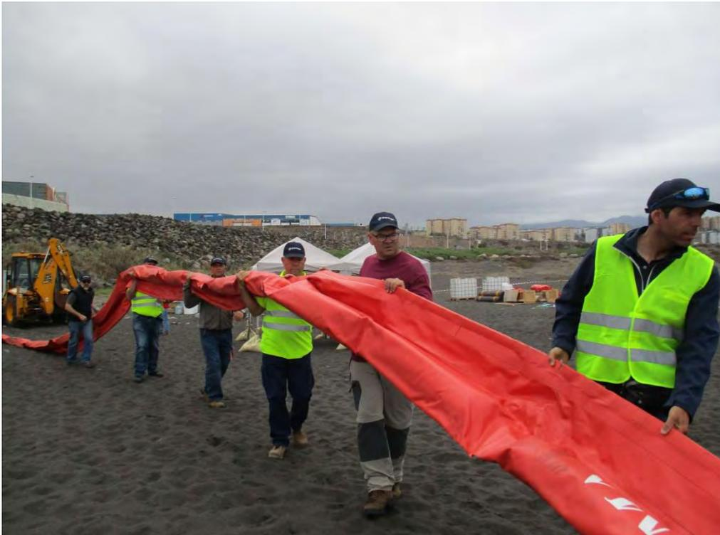
**Figura 14.** Despliegue de uno de los tramos de la barrera cilíndrica rígida.
