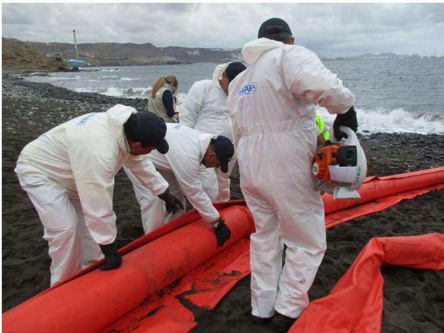
**Figura 20.** Inflado de la cámara de aire de la barrera selladora.
