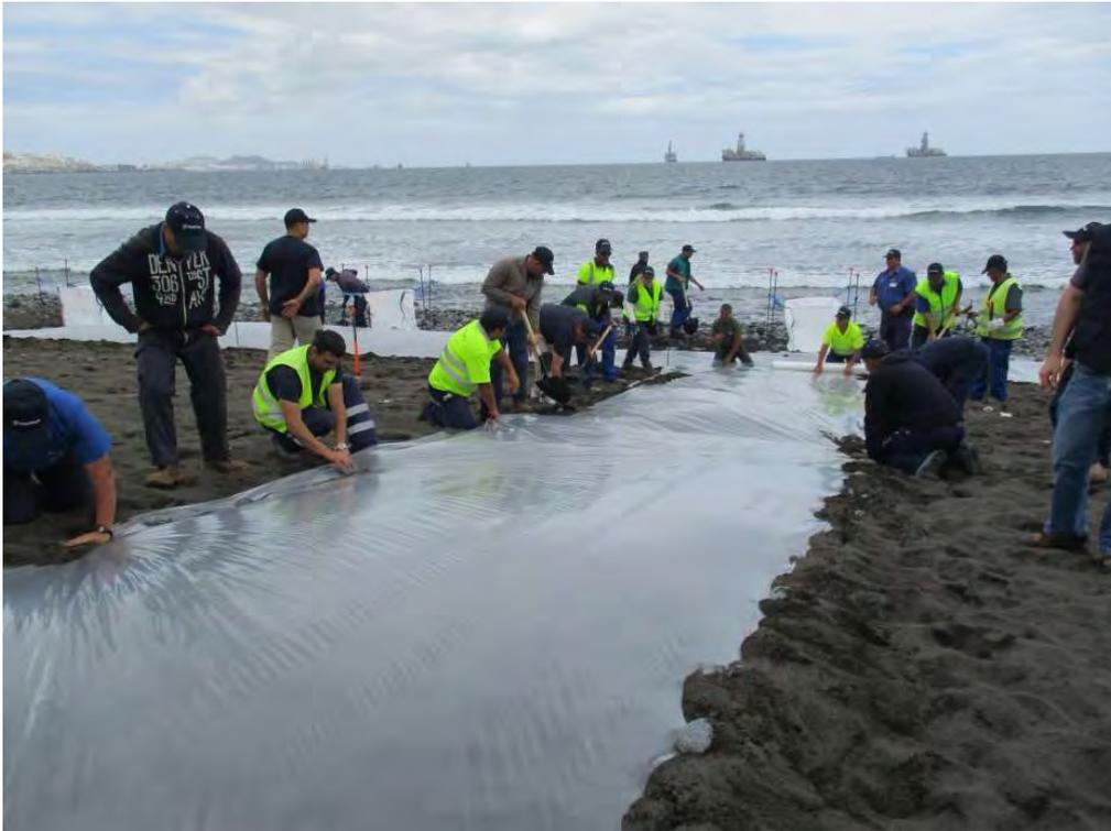
**Figura 11.** Establecimiento de corredor de descontaminación con polietileno.
