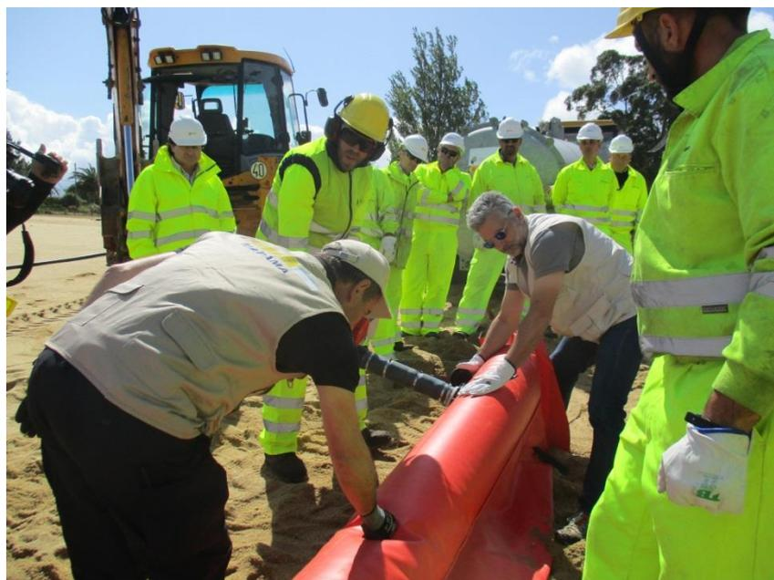
*Ilustración 15. Llenado de aire de la cámara superior de la barrera selladora.*
