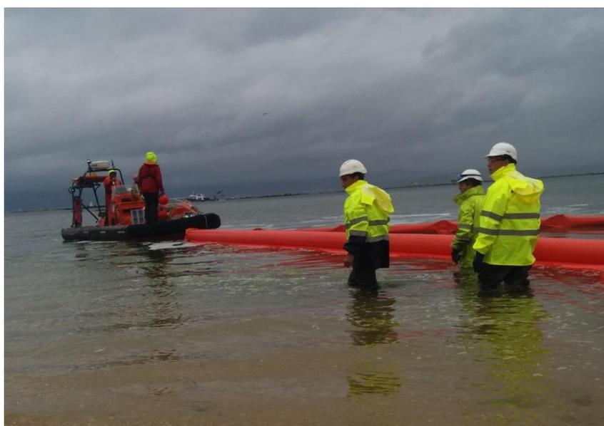
*Ilustración 25. Personal equipado con vadeadores y embarcación auxiliar durante el largado de la barrera.*
