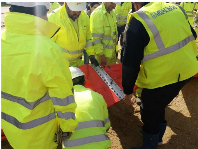
*Ilustración 14. Empatado de la barrera selladora con la barrera cilíndrica.*
