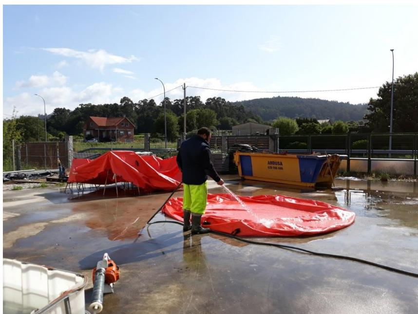
*Ilustración 33. Limpieza de tanque autoportante.*
