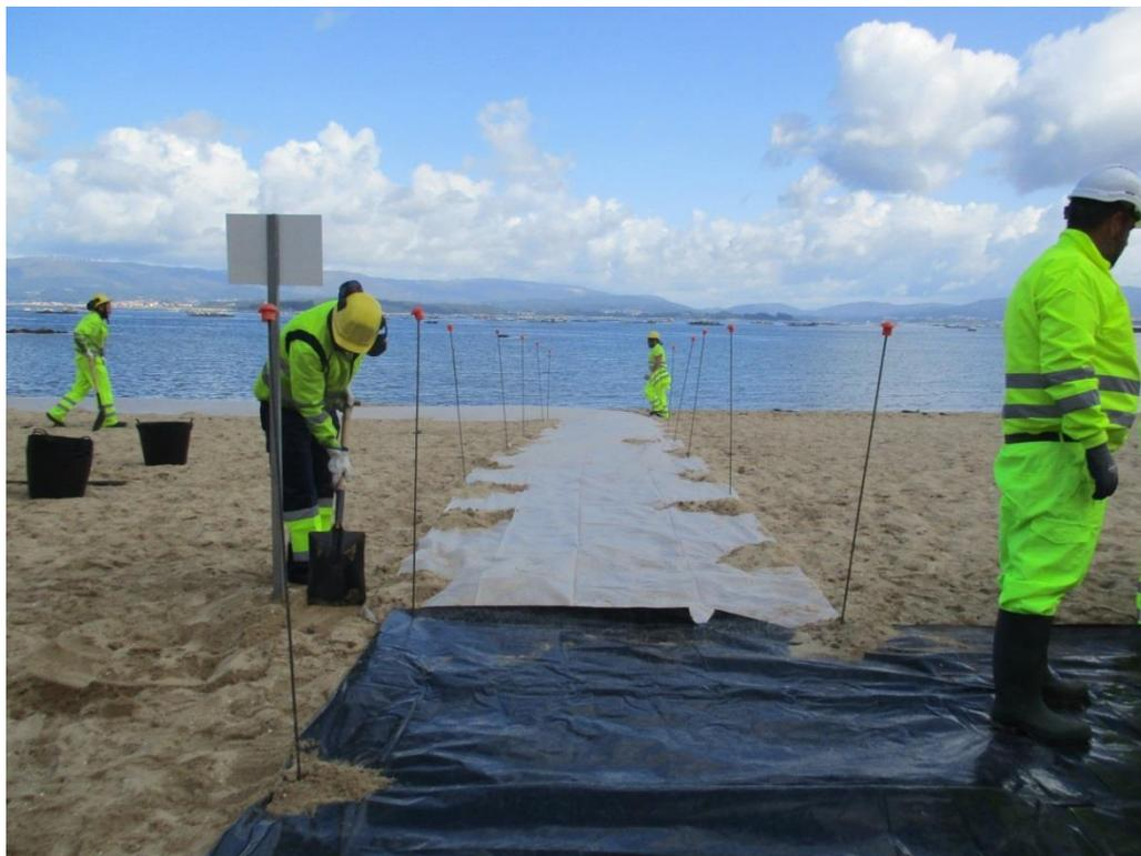
*Ilustración 12. Corredor de descontaminación junto a la zona de almacenamiento de residuos.*
