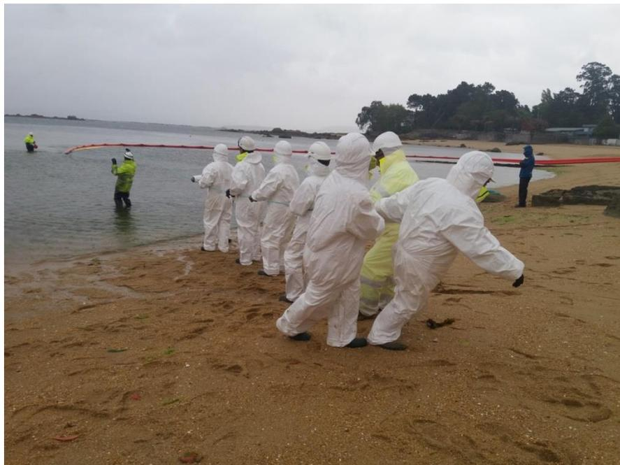
*Ilustración 27. Acercamiento de barrera a la orilla para contención de vertido.*
