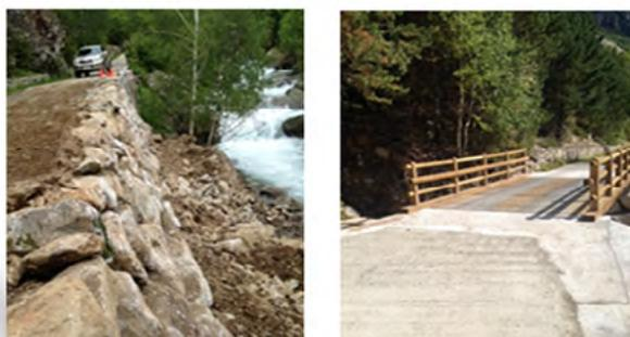
*Escollera en ejecución y pontón de nueva construcción en la pista de Aigüestortes.*
