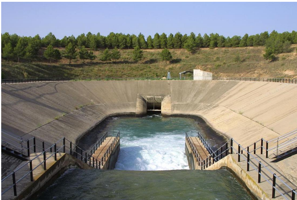
Ilustración 5: Cámara de carga del túnel de Talave en el Trasvase Tajo-Segura.
