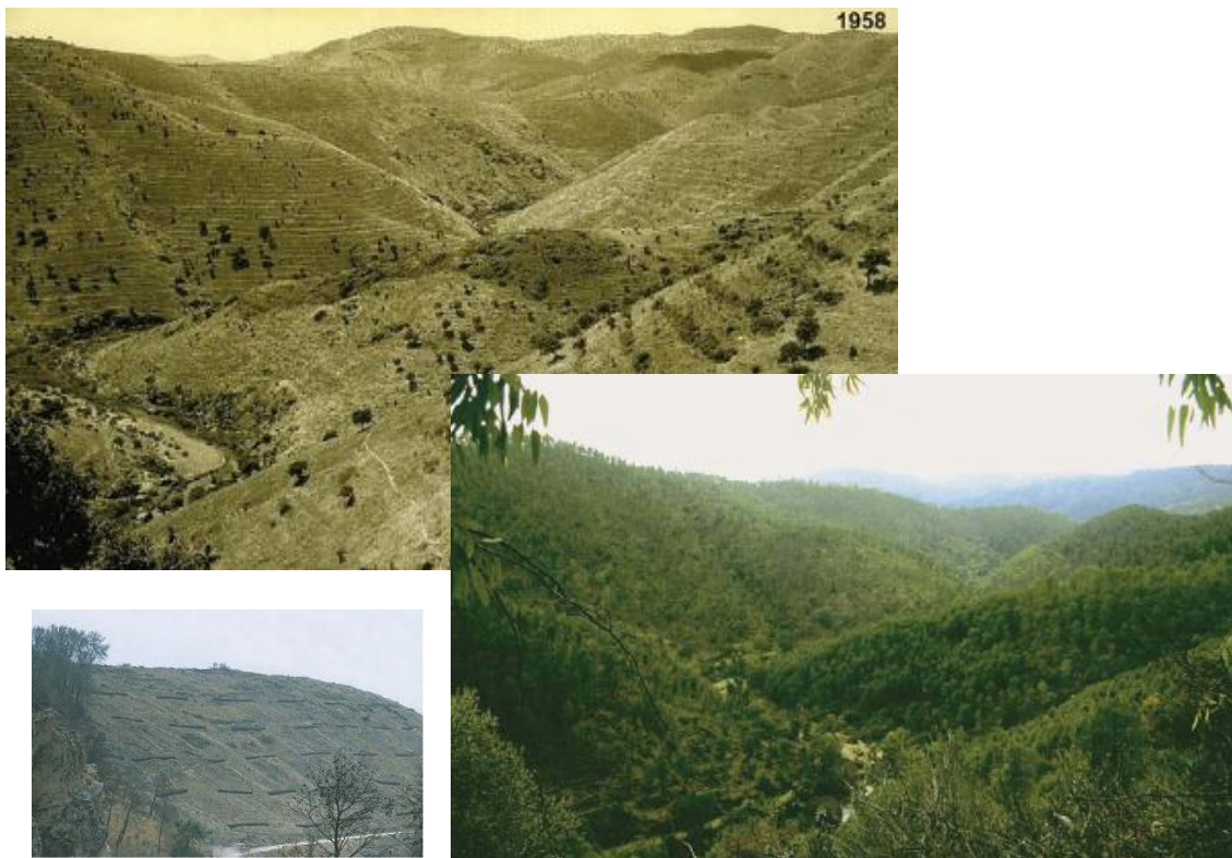
Ilustración 1: Restauración hidrológico forestal realizada en el año 1958 en el Parque Natural de la Sierra de Hornachuelos (Córdoba) y situación actual. Esta restauración ha sido esencial para el control de la erosión y el uso del agua en toda la cuenca hidrográfica.
