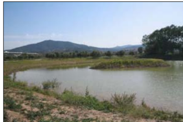
Zona de actuación después de las obras (Jul-07)
