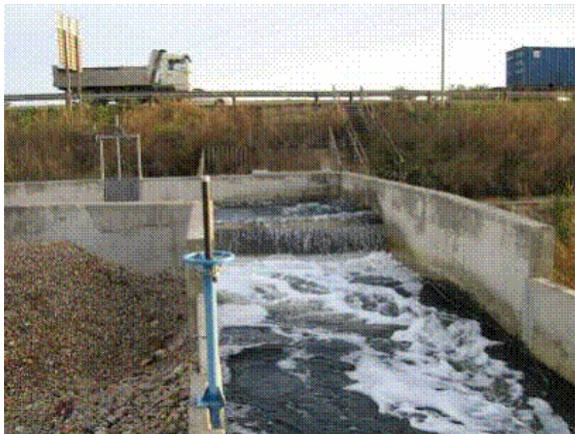
Cuenca del Júcar. Reutilización: enlace EDAR de Pinedo (tratamiento terciario), con acequia de Oro.
