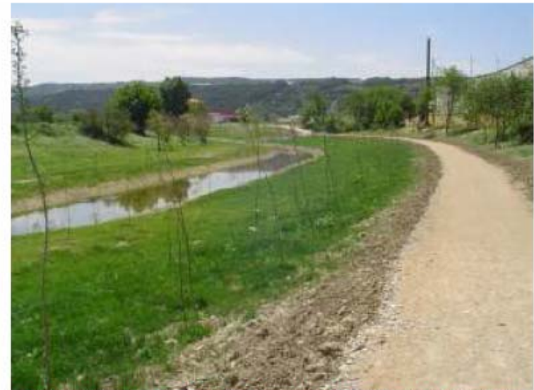
Reduccion de la seccion transversal del meandro con taludes tendidos que permiten el desarrollo de la vegetación
