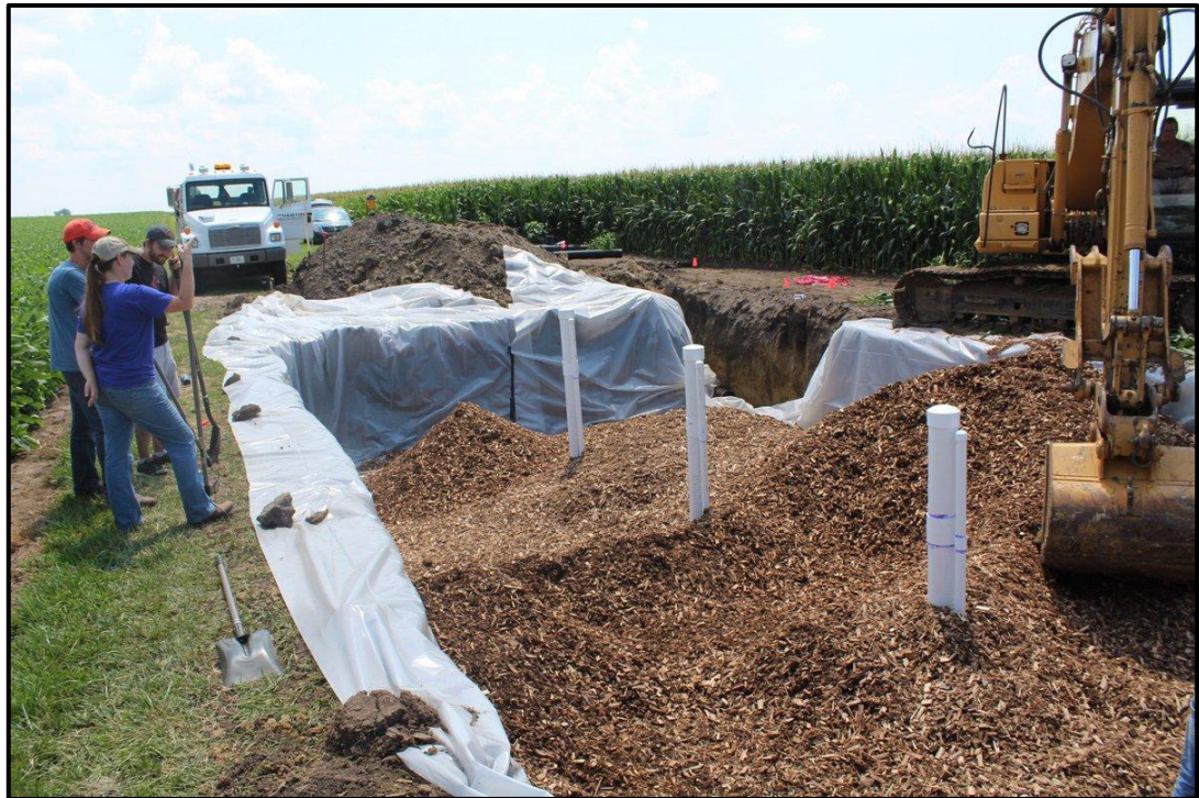
Figura 3. Relleno de un biorreactor con astillas de madera (EEUU). Foto: Janith M. Chadrasoma.
