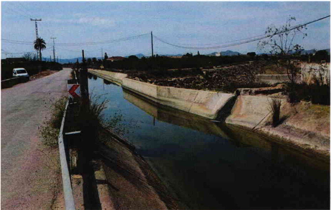
Figura 6. Realce de solera en la obra de paso de la Rambla del Albuñón en su intersección con el Canal Principal de la CRCC.
