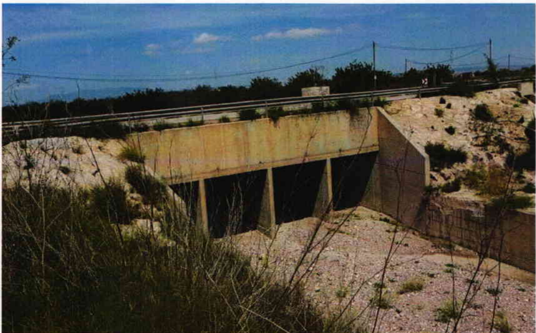
Figura 7. Aspecto de la obra de paso de la Rambla del Albuñón en el Canal Principal de la CRCC.
